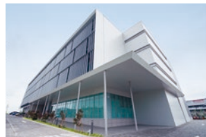
外観(ライフィノベーションセンター・ 神奈川県川崎市)
